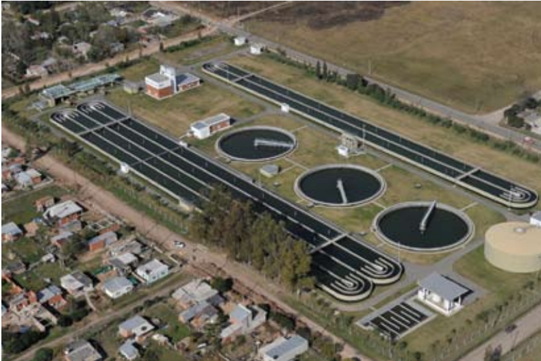
■ Planta de tratamiento cloacal. Merlo
