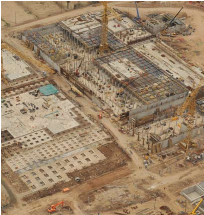
■ Planta potabilizadora de Tigre. Provincia de Buenos Aires
