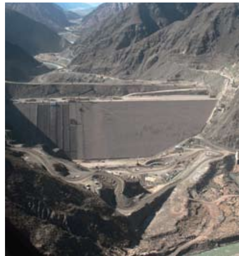
■ Central Hidroeléctrica Caracoles. San Juan
